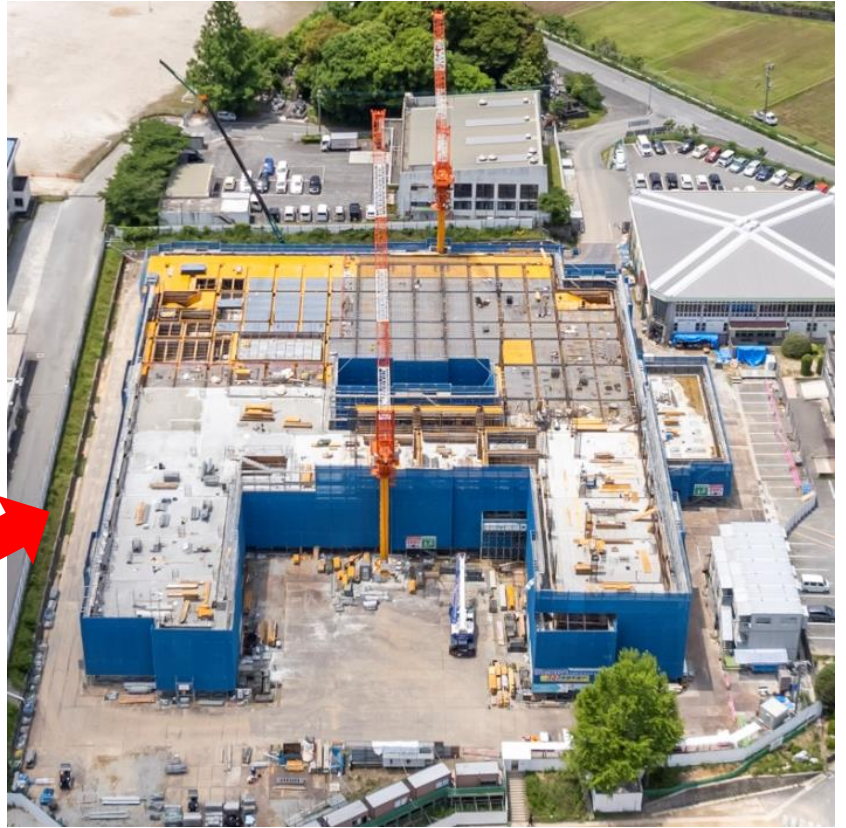
< 5月撮影の新校舎 > 3階の天井部分の様子。 工事は順調に進んでいると報告を受けています。
